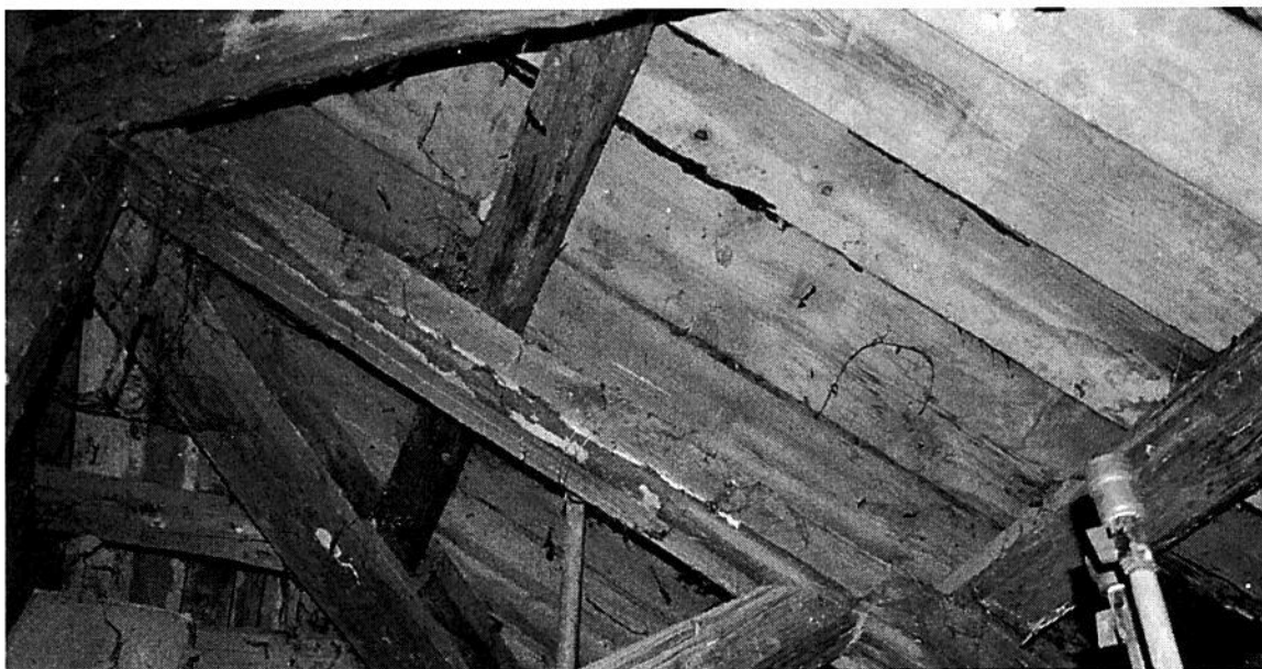
Figura 2 - Immagine carpenteria in legno sotto la copertura
